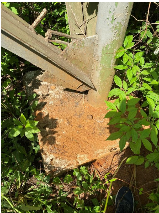
Фото №26-29. Состояние железобетонных фундаментов.
