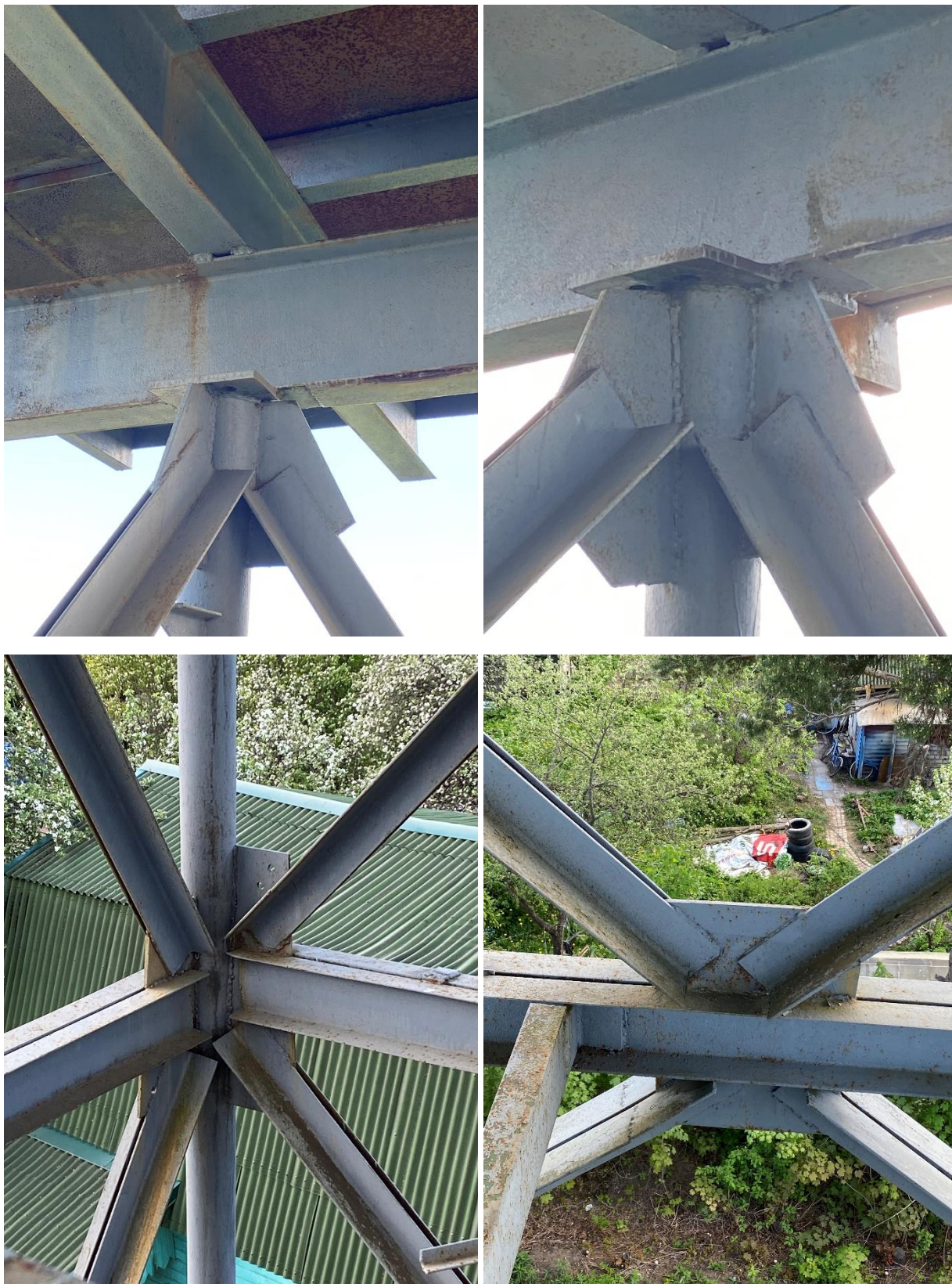
Фото №22-25. Состояние узлов несущей конструкции каркаса башни.
