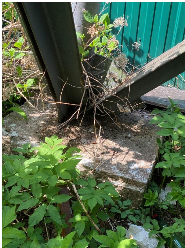
Фото №26-29. Состояние железобетонных фундаментов.
