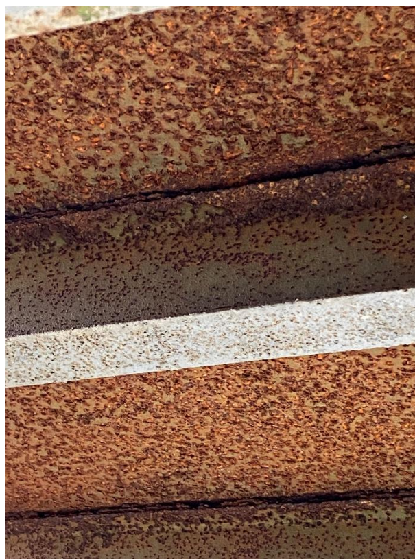
Фото №19-21. Коррозионные повреждения верхних полок двутавров обвязки верхней площадки.
